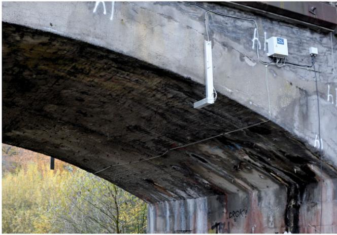
**Bild 9** Rissüberwachung an der Bogenunterseite
