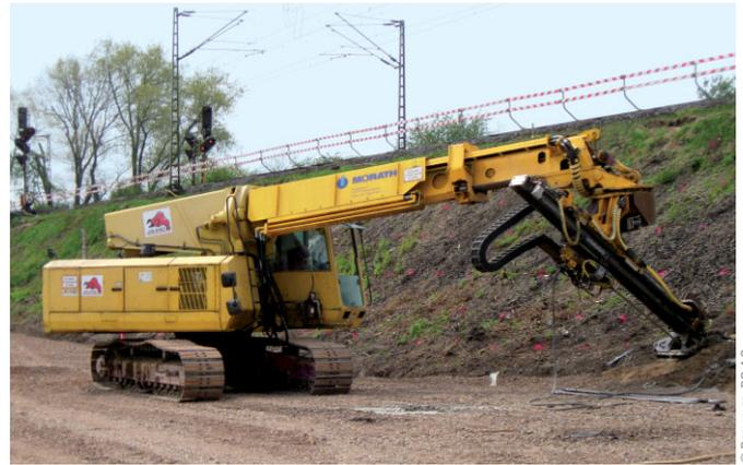
**Bild 19** Vernagelung des Bestandsdammes durch Mikropfähle
